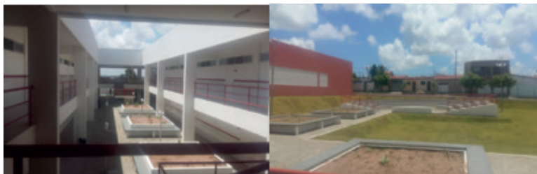
Figura 1: CEEP de São Gonçalo do Amarante/RN
